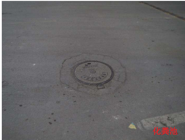
图 4-1 化粪池现场照片
